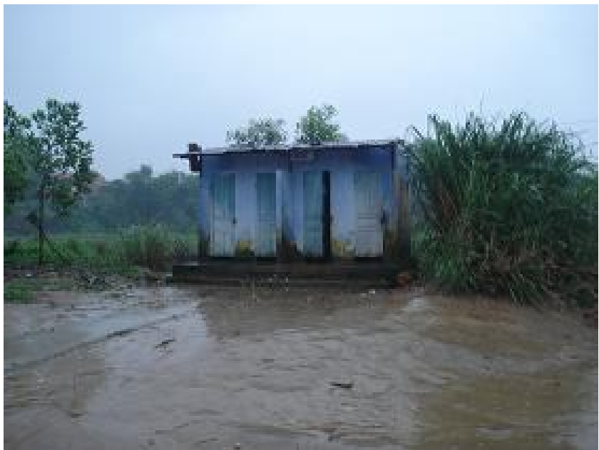
Nhà vệ sinh tập thể của tổ 11, Phường Phú Bình
